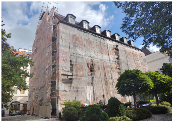
W trakcie remontu elewacji
