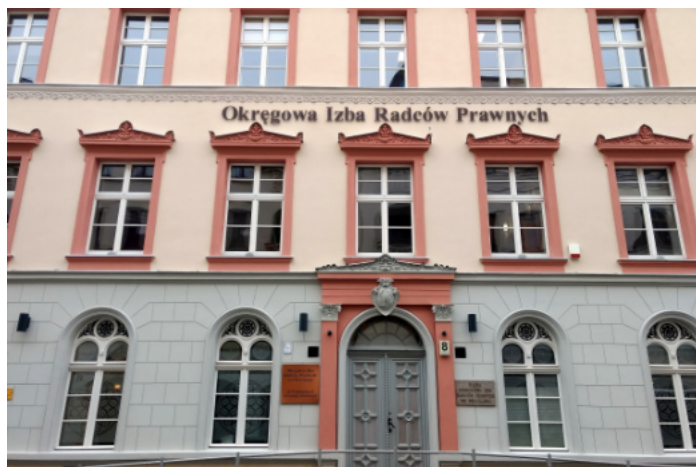
Po zakończonym remoncie elewacji
