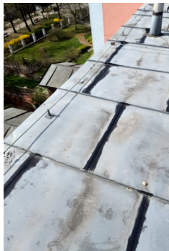
Dach – remont pokrycia
