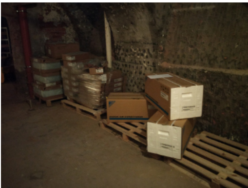
Piwnica w trakcie remontu Fot. OIRP we Wrocławiu
