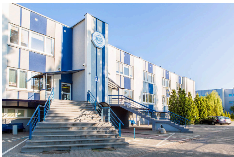
Budynek WSB we Wrocławiu
