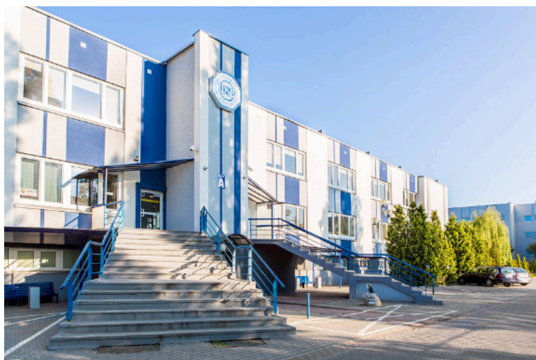
Budynek WSB we Wrocławiu
