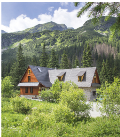
Tatliakova Chata – po krótkim odpoczynku ruszamy dalej; fot. http://tatliacka.sk/
